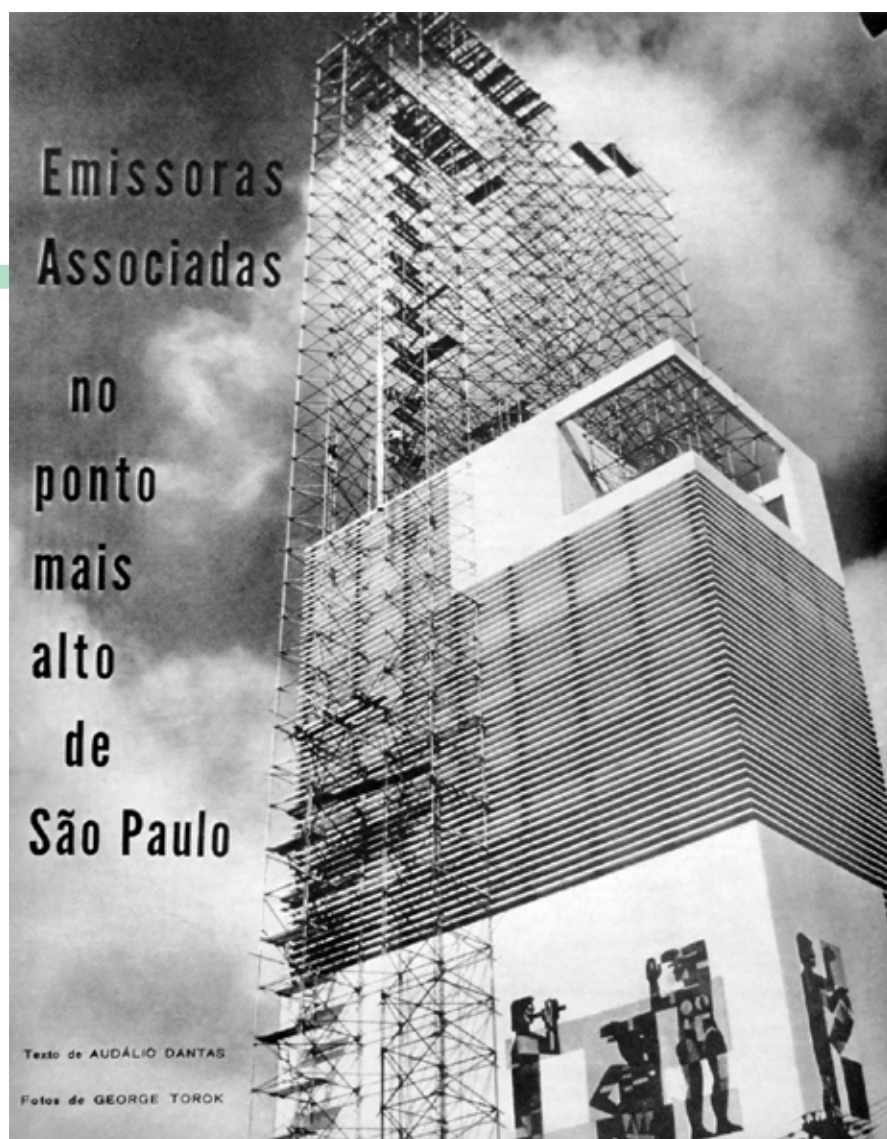
Estrutura provisória erguida desde o solo para levar os materiais até o topo do edifício e realizar a montagem da nova torre do Canal 4 (A Cigarra/George Torok/reprodução).
