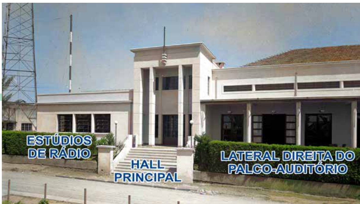
A fachada original do prédio principal da Cidade do Rádio e seus devidos setores (foto original: Aristodemo Becherini, "Rádio Difusora", 1942/Acervo Fotográfico do Museu da Cidade de São Paulo).
